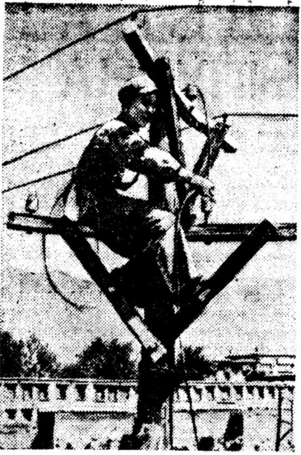
Бойцы Китайской Народно-освободительной армии помогают населению Тибета обрабатывать землю, строить дороги и орошительные каналы, проводить линии электропередачи. На снимке: боец Народно-освободительной армии ремонтирует линию электропередачи в Лхасе. Снимок из китайского журнала «Жемчужина Тибета»
